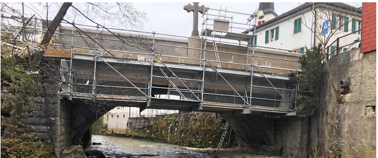
Provisorisches Baugerüst bei Verstärkung
