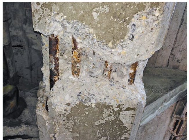
Korrodierte Innenbewehrung
