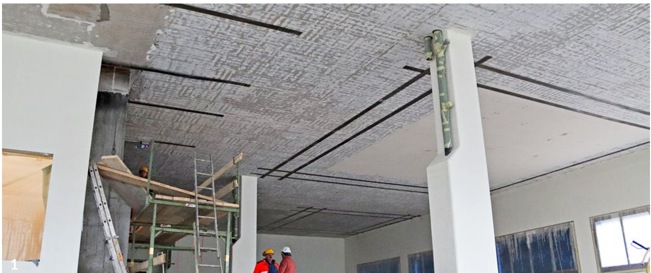
Typische Verstärkung des positiven Biegemomentes mit re-plate
