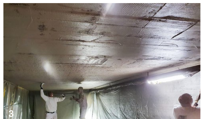
Brandschutz für re-plate in Kombination mit CFK-Lamellen
