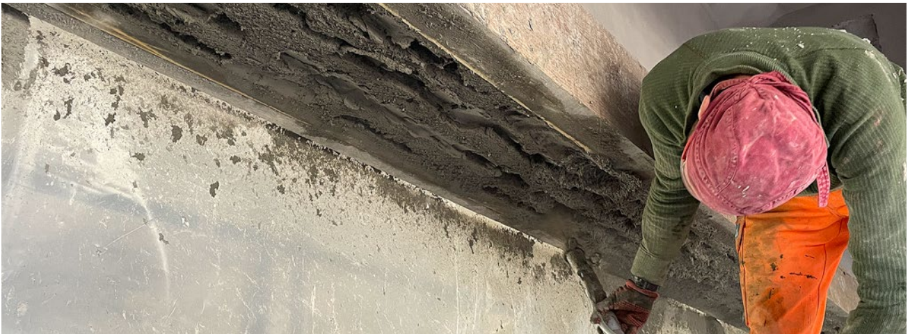
Einbetten von re-bar mit Sika Spritzmörtel
