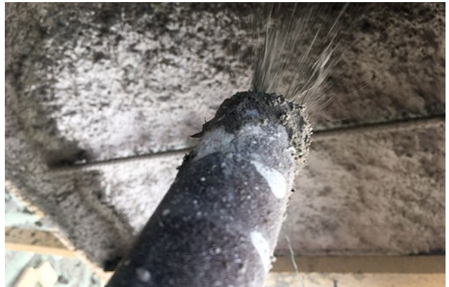
Einspritzen des Mittelbereiches mit Sika MonoTop®
